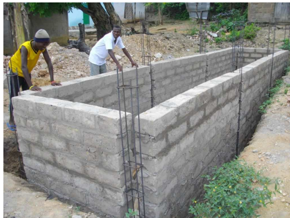
L'avancement du chantier une semaine plus tard
